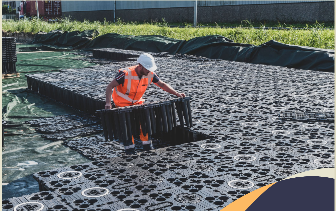
Unidad de infiltración AquaCell fabricada con material 100% reciclado
