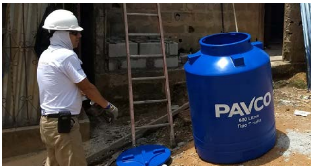
Voluntarios de Wavin instalando un sistema de captación de agua pluvial.
